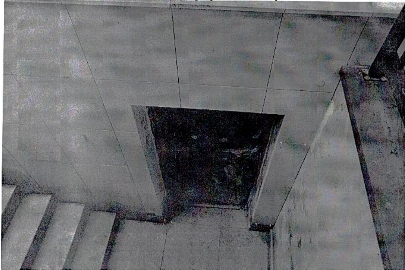
Zdjęcie nr 17 – widok na wejście z zewnątrz do podpiwniczenia budynku
