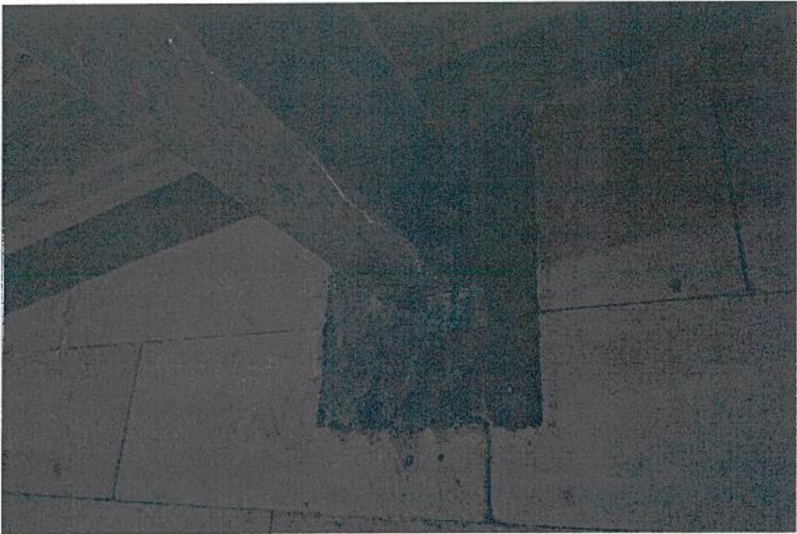
4) Brak wykonania impregnacji murlat drewnianych w miejscach kotwienia ich do wieńca.
