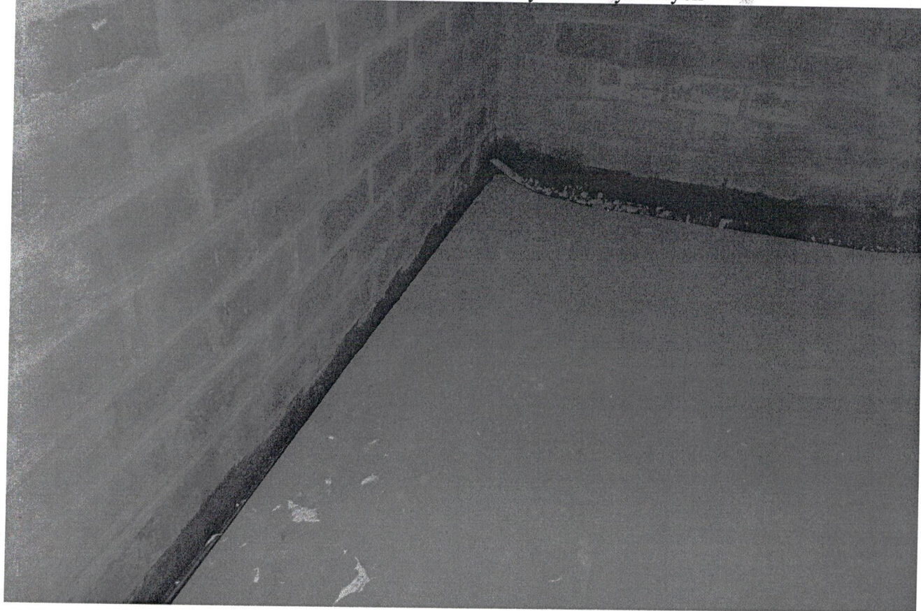
Zdjęcie nr 6 – zawilgocenie ścian pomieszczeń technicznych nieużytkowych
