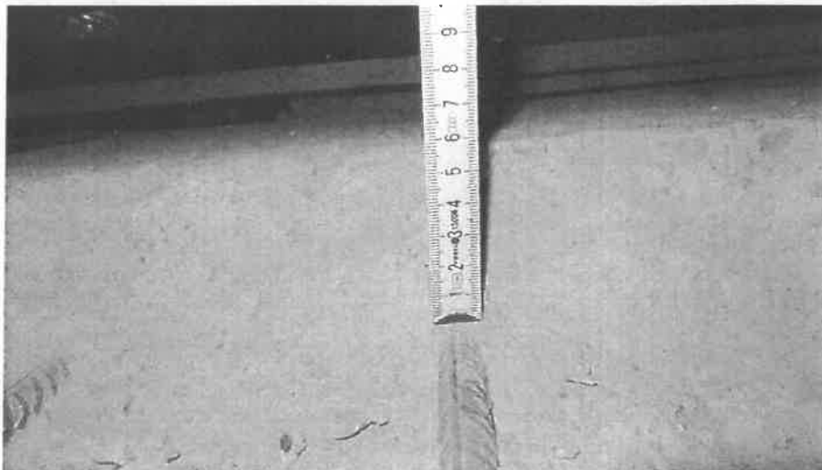
Rys. 6. Pomiar otuliny zbrojenia górnego w stropie P7
